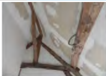
AVANT : pièce à isoler, ancienne isolation intérieure derrière le placo Photos : S. Declercq, A. Bimeaux
